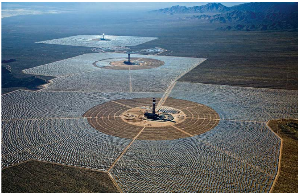
Rys 4: Elektrownia słoneczna - kolektory, Kalifornia
