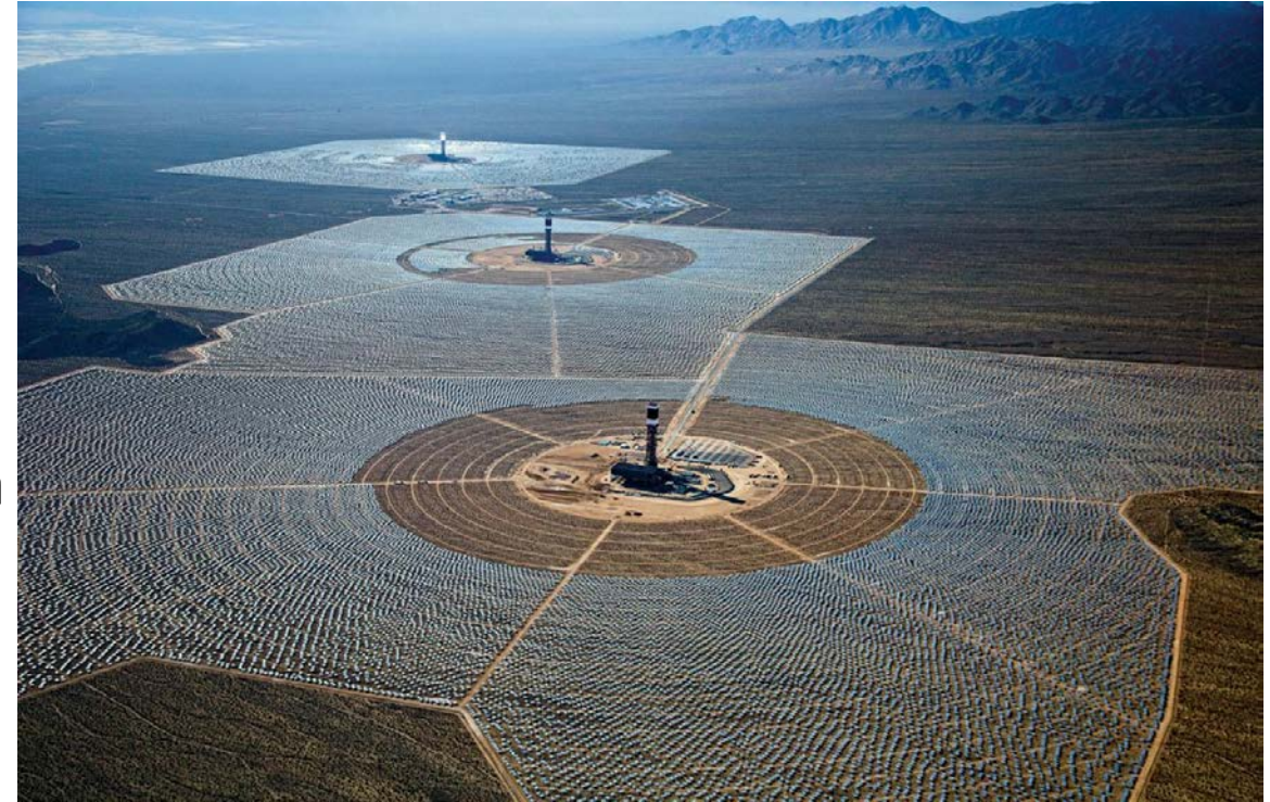
Rys 3: Elektrownia słoneczna - kolektory, Kalifornia
