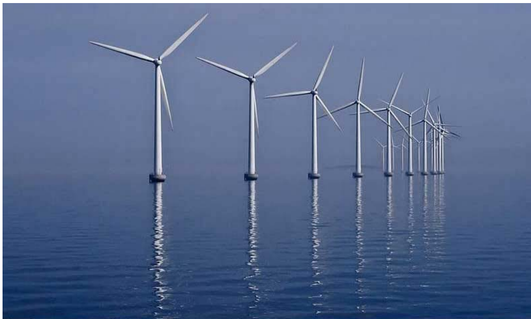
Rys 2: Elektrownia wiatrowa, Kopenhaga
