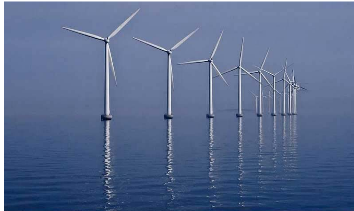
Rys 2: Elektrownia wiatrowa, Kopenhaga
